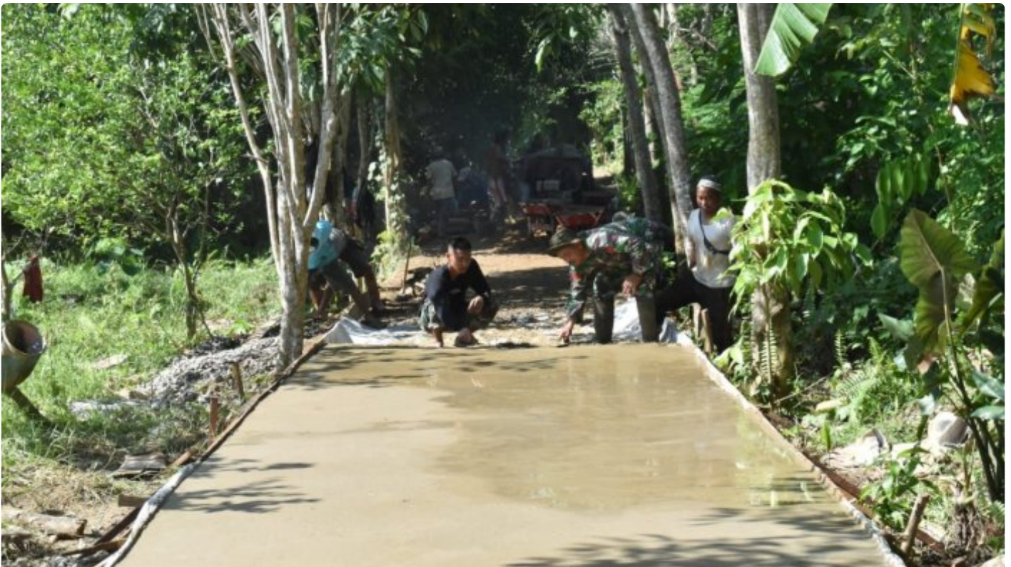
Semangat Warga Hapulang Rampungkan Jalan Desa
